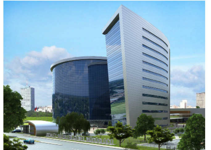
DSİ Genel Müdürlüğü | Yangın Kapısı
