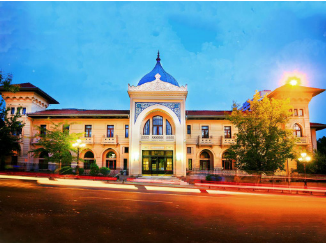
Ankara Palas | Yangın Kapısı
